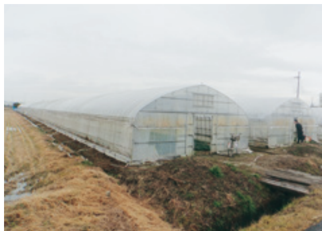
木津川右岸に24棟が並ぶハウス群
